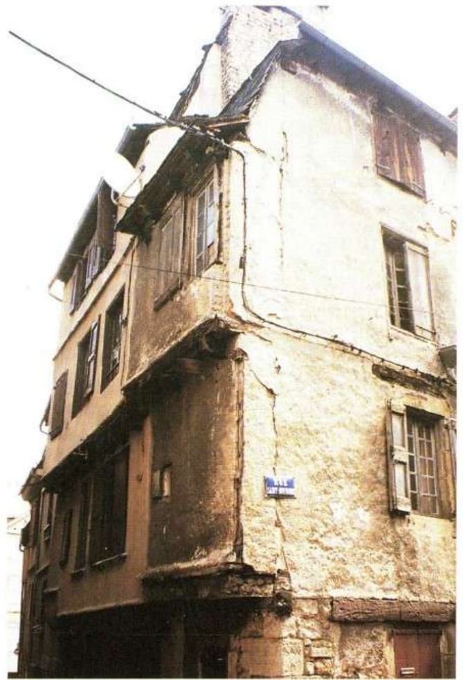
▲ RUE DU FOURNET ▼
